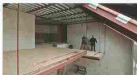
Ocelové rámy svařené z U nosníků nesou v rozích navařené ocelové táhla
