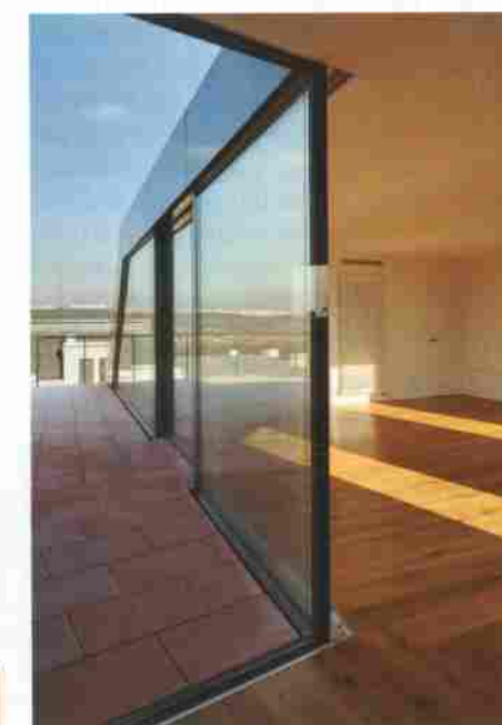
Oproti původnímu stavu stačilo přidat nástavbu i k východnímu štítu a propojené střechy u terasy svisle oříznout a prosklit
