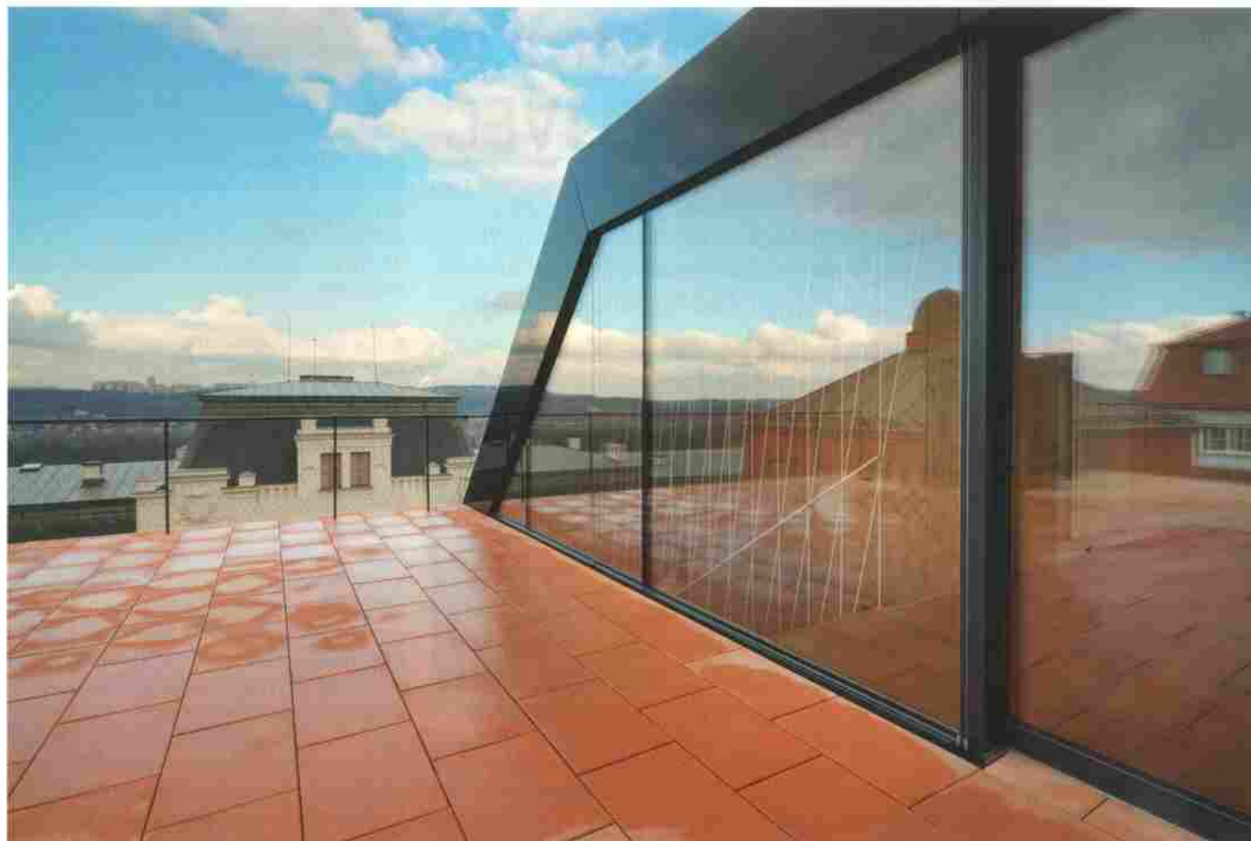
Pod novou střechou vznikly nové byty, jeden z nich má velkorysou terasu a dvě obytná patra
