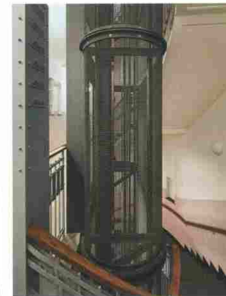
Šachta výtahu tvoří tubus z drátěné sítě, který svým zaoblením reflektuje tvar schodiště
